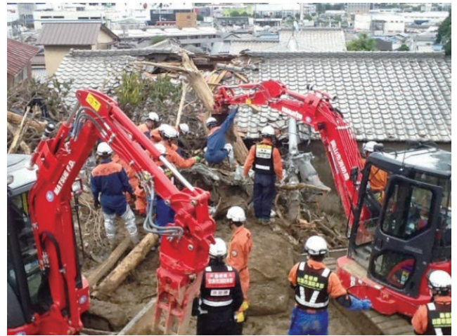
重機による活動 （平成26年8月27日・広島市） （岡山市消防局提供）
